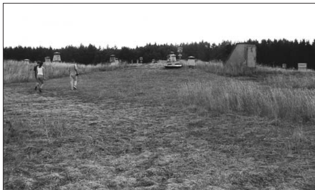
Fig. 1. Fragment pola podziemnych zbiorników z paliwem. Ścieżka przepływu oleju napędowego zaznacza się brakiem roślinności
