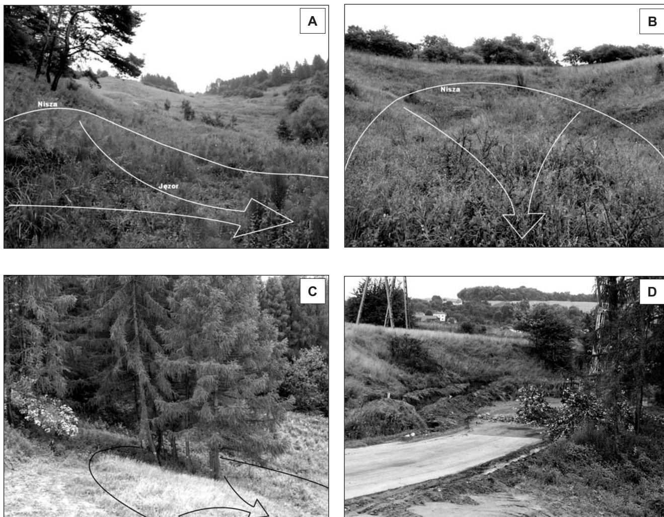
Fig. 2. Osuwiska na terenie górnego odcinka planowanej kolejki linowej w Przemyślu
