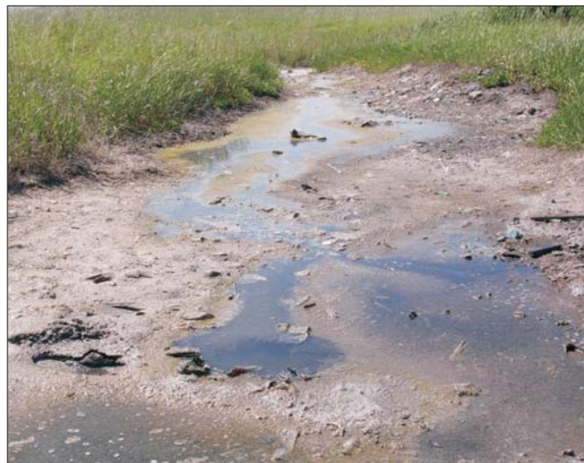
Fig. 7. Wysiek w miejscu dawnego szybu w Szczerbakowie
