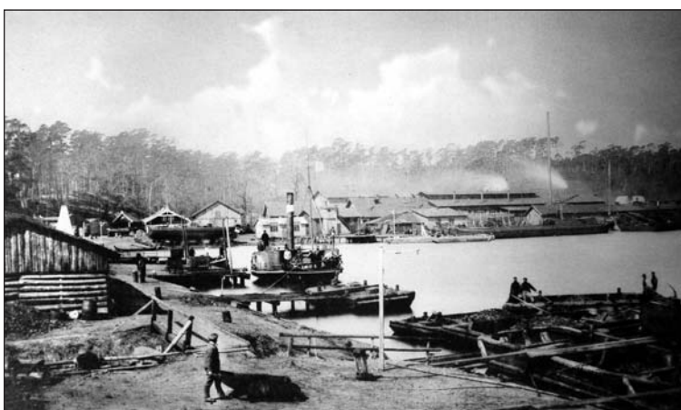
Fig. 5. Bagrowanie przez firmę Stantien & Becker Zatoki Kurońskiej w Juodkrantė (niem. Schwarzort) – budynki i urządzenia zakładu wydobywczego (Klebs, 1883)
