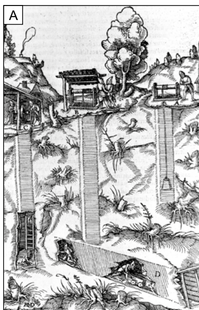
Fig. 8. A. Przekrój przez średniowieczną kopalnię, obrazujący trzy pionowe szyby z podziemnymi wyrobiskami. Rycina zamieszczona w pracy Agricoli (1556), polski przedruk (2000). B. Współczesna forma rzeźby terenu, powstała przez zapadnięcie szybu z wyrobiskiem. Pole pingów na wierzchołku Młynika Dużego w okolicy Leszczyny (por. fig. 9)
