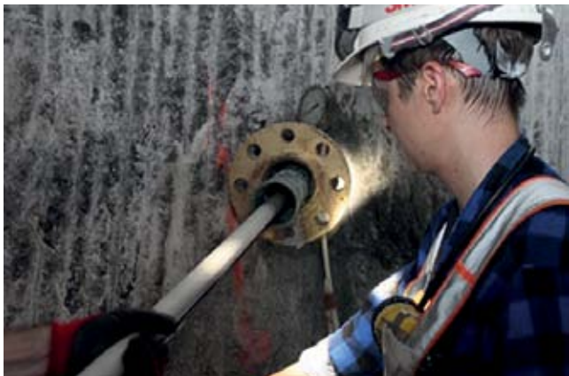
Fig. 6. Pomiar georadarem otworowym w otworze wiertniczym
