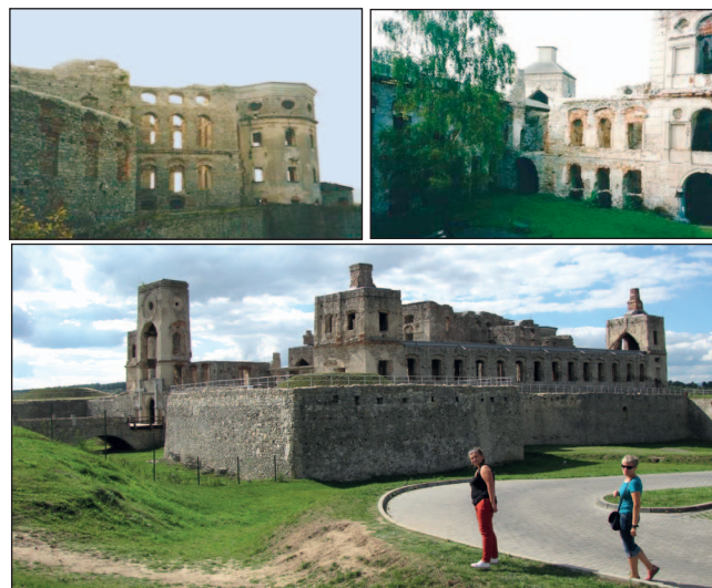
Fig. 3. Widok na ruiny zamku Krzyżtopór (fot. E. Sermet, M. Nieć)
