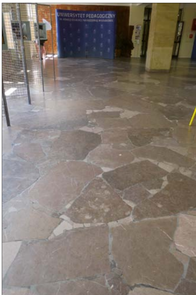
Fig. 1. Ogólny wygląd posadzki w holu głównym na pierwszym piętrze. Widoczne różnej wielkości, nieregularne płyty, różnych rodzajów „marmurów” świętokrzyskich spojonych zaprawą cementową
