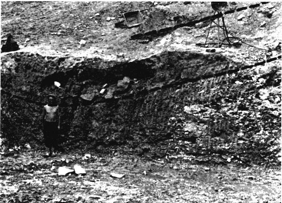
Fot. 2 Synklina na północnej ścianie wykopu w Pychowicach Ławica piaskowca obwiedziona liniami przerywanymi
